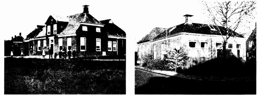
De dorpsherberg van Van Zijl, Oude Winsumerstraatweg 6. In 1887-1889 in gebruik als "noodkerk". Schoolgebouw en kosterij op de hoek Kerkstraat-Schoolstraat.
