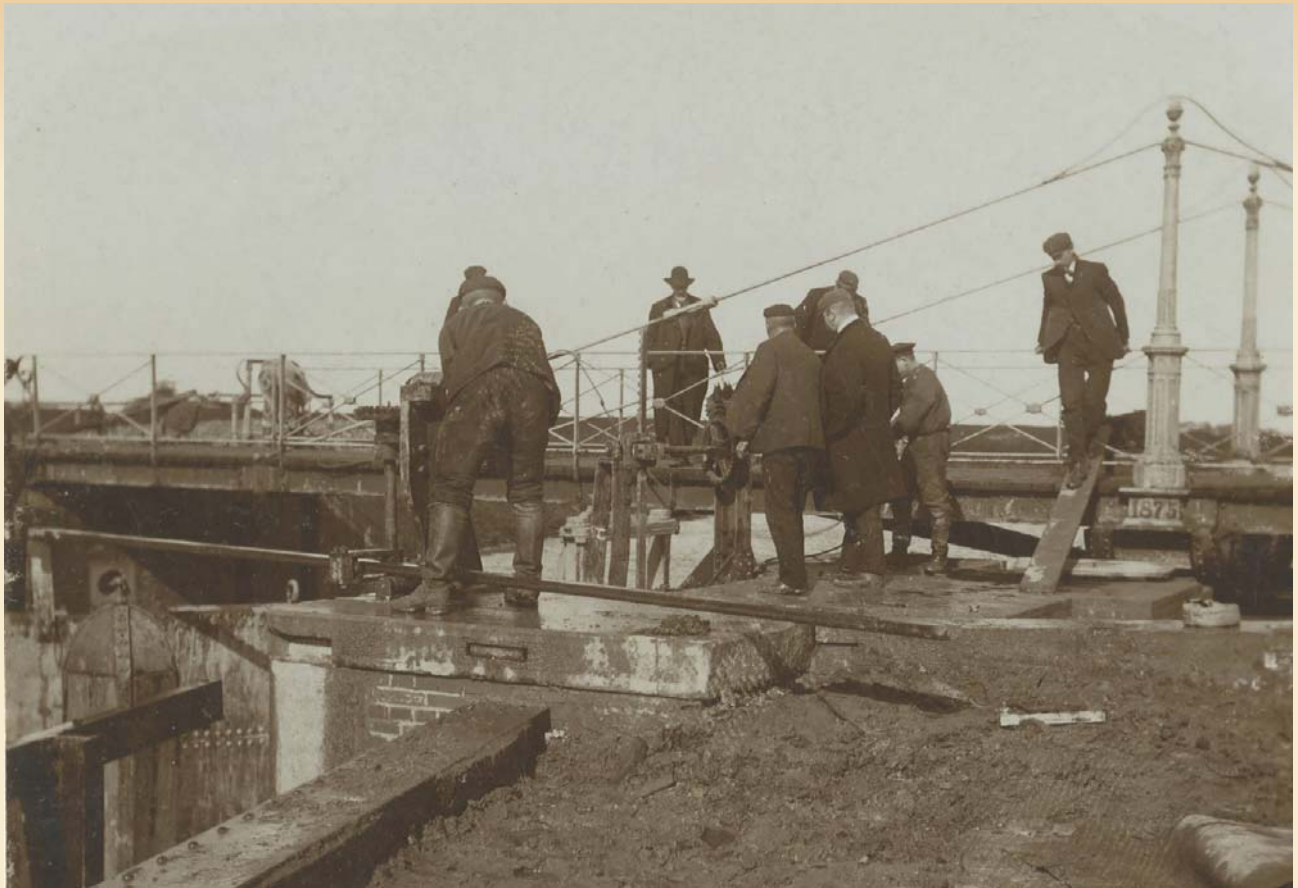
nr. 818-21384 van Beeldbank. Schutsluis Reitdiep tijdens herstelwerkzaamheden in 1905. Credits: Foto collectie RHC Groninger Archieven (818/21384)
