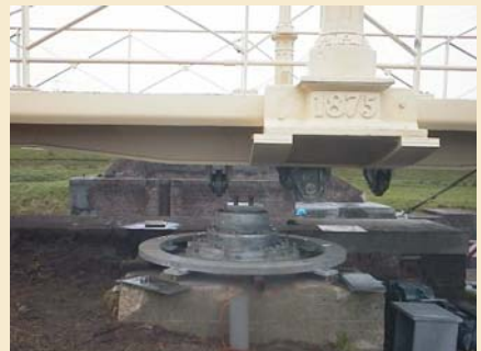
plaatsing van de nieuwe draaibrug op de nieuwe spil
