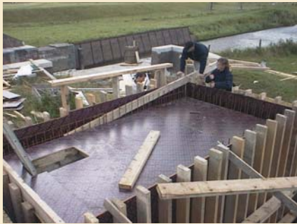
aanleg van de bekisting
