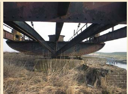
dwarsdrager bij de spil van de oude draaibrug
