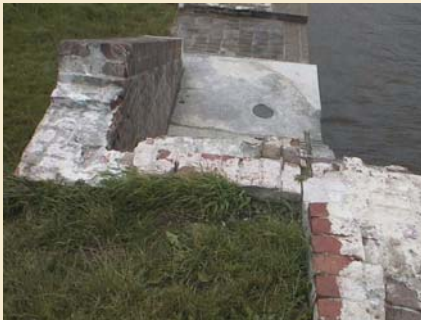
metselwerk bij de vooroplegzijde aan de zuidkant van de draaibrug
