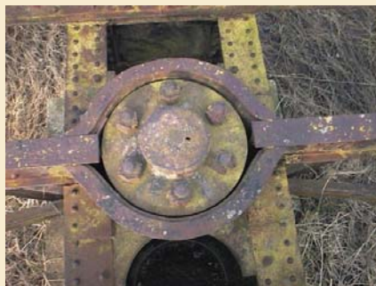
spilconstructie van de oude draaibrug
