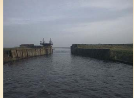
de oude sluis, gezien vanuit het zuiden
