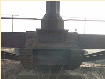
pylaster met ondersteuning van de oude draaibrug met het jaartal 1875
