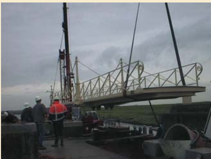
de nieuwe draaibrug wordt van het ponton gelicht
