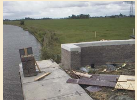
metselwerk en betonwerk aan de westzijde van de draaibrug
