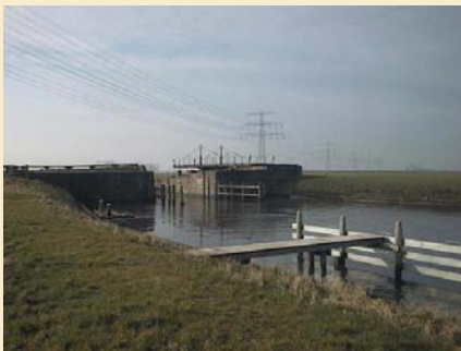
de oude sluis, gezien vanuit het noorden
