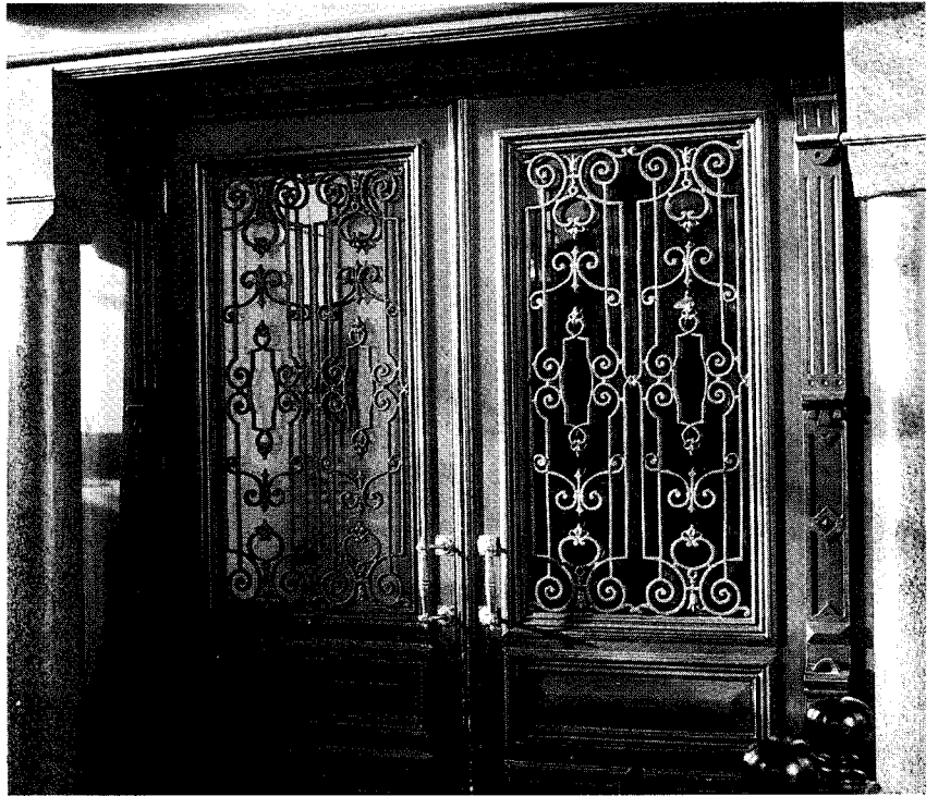
De tochtdeuren met hun fraaie tralies in ijzersmeedwerk.
